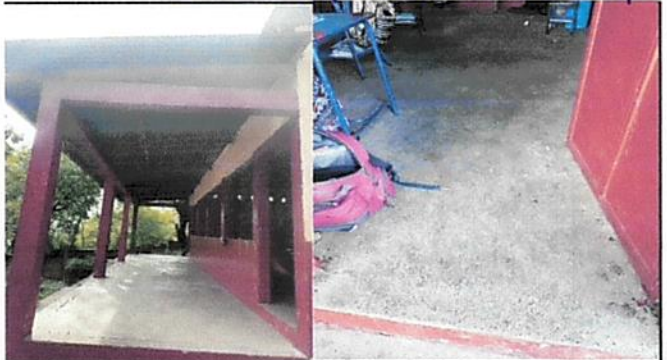
Foto 2: CAMBIO DE PISO DE CONCRETO POR PISO CERAMICO MODULO 1
