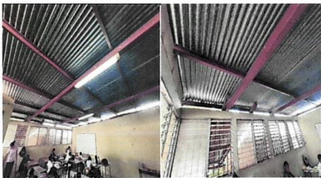
Foto 3: CAMBIO DE TECHO MODULO 2
