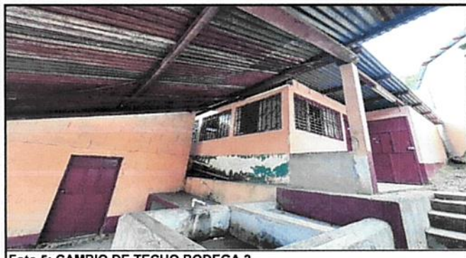
Foto 5: CAMBIO DE TECHO BODEGA 2
